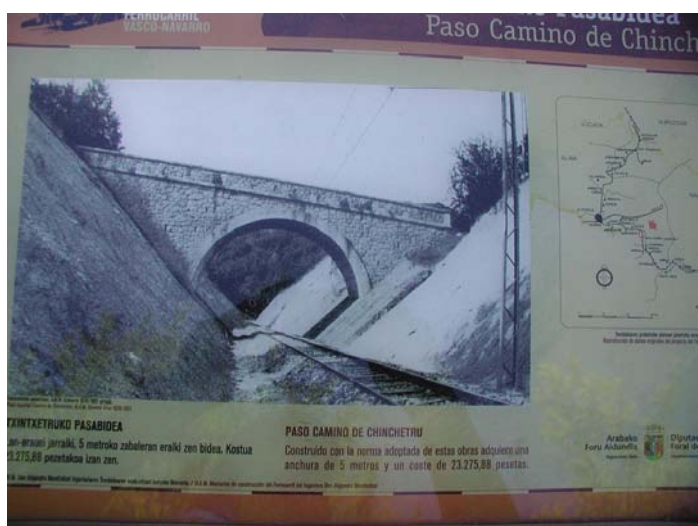
Puente del camino de Chinchetru.
