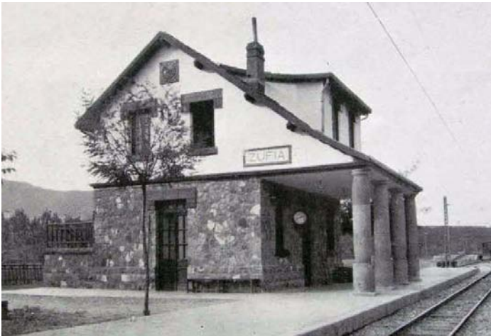
Estación de Zufia
