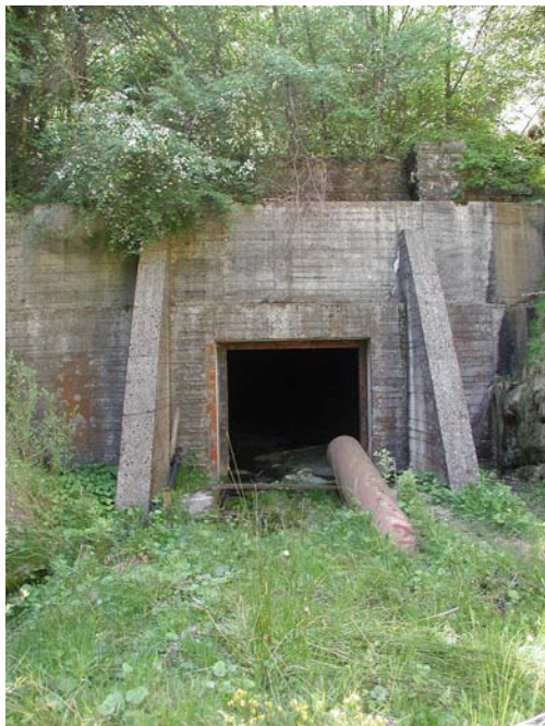
Tunel de Laminoria. Boca del lado de Vitoria. Se usó para trasvasar agua durante la sequía; por eso tiene el refuerzo de hormigón y la tubería metálica.
